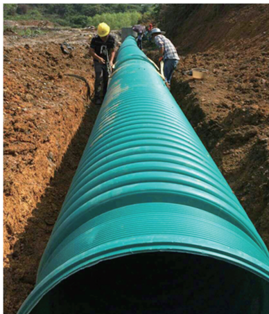
图 11 正在安装中的超高分子量聚乙烯排水管
